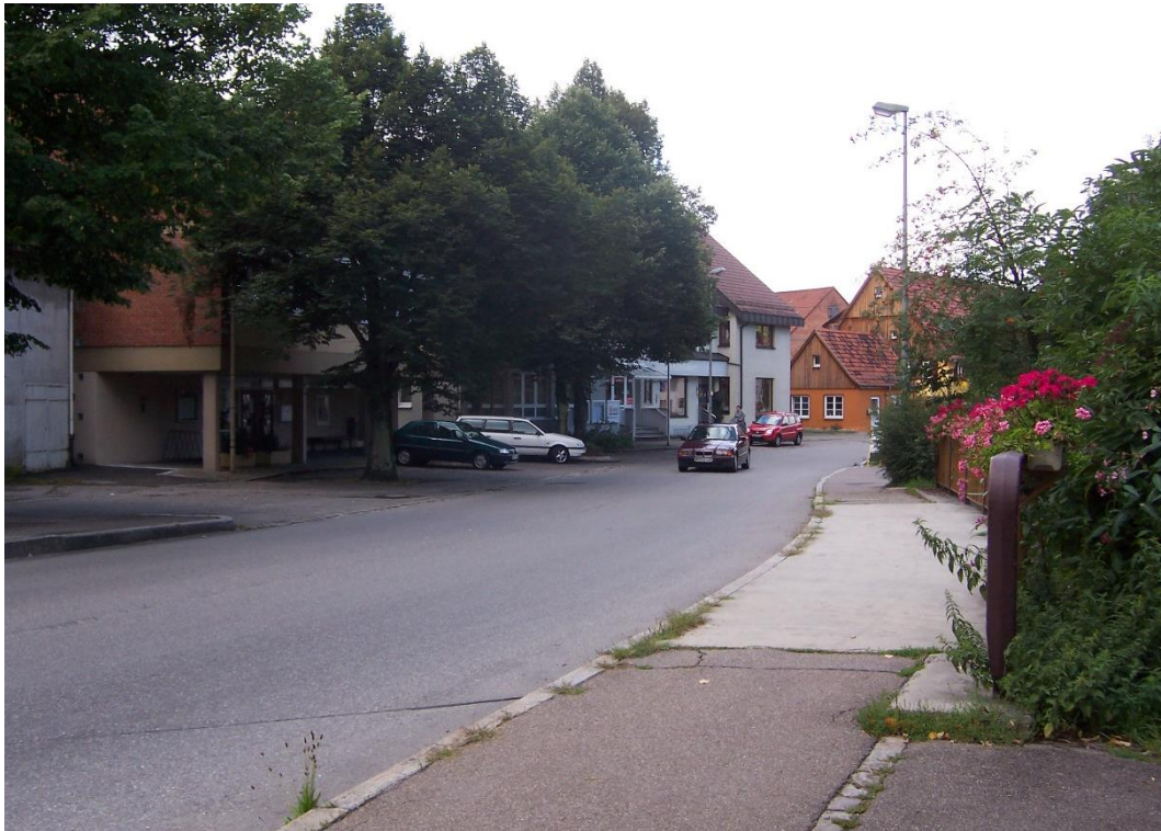
Abb. 4.23: OD Schlechtbach, Rathausplatz – Südseite mit Wieslaufbrücke, Bestand
