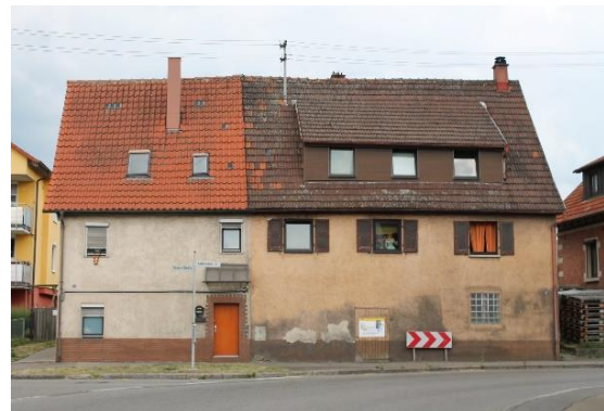
Abb. 4.1: Umfassender Modernisierungsbedarf bzw. Abbruch und Neubau, Heilbronner Straße, Haus Nr. 1+2 [WHS 2019]
