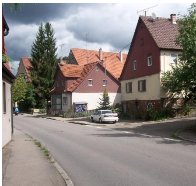
Abb. 4.17: Einmündung Brunnenstraße Stuttgarter Straße, Blick nach Norden
