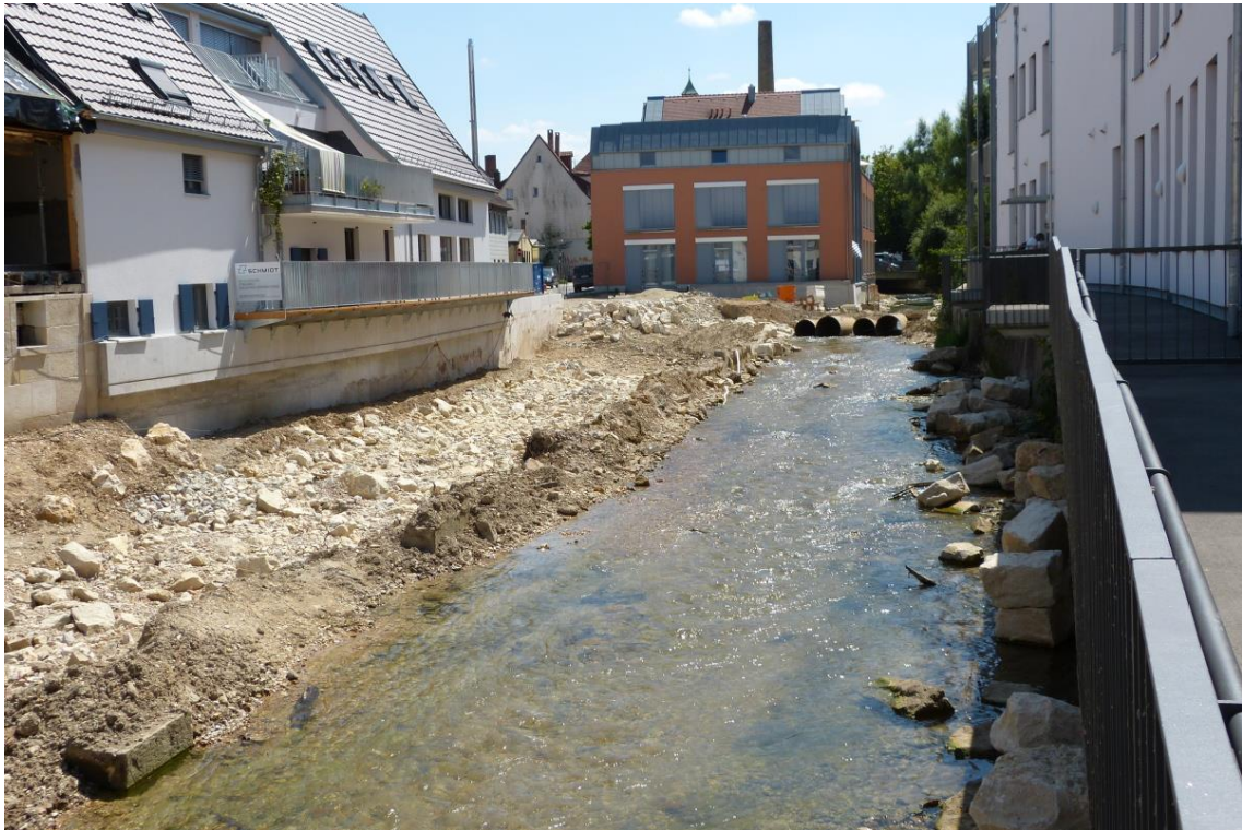
Abb. 4.36: Beispiel Kirchheim unter Teck – Renaturierung eines verbauten Gewässers (Lauter)
