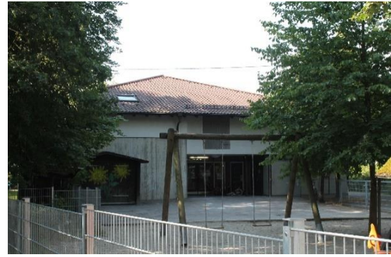
Abb. 4.3: Modernisierungsbedürftiges Gebäude, Kindergarten, Pappelweg 9 [WHS 2019]
