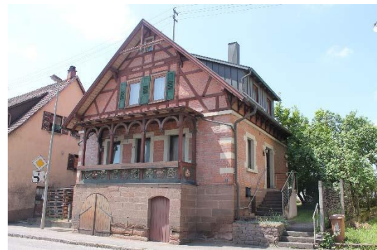
Abb. 4.5: Denkmalgeschütztes Gebäude mit umfassendem Modernisierungsbedarf, Heilbronner Straße, Haus Nr. 3 [WHS 2019]
