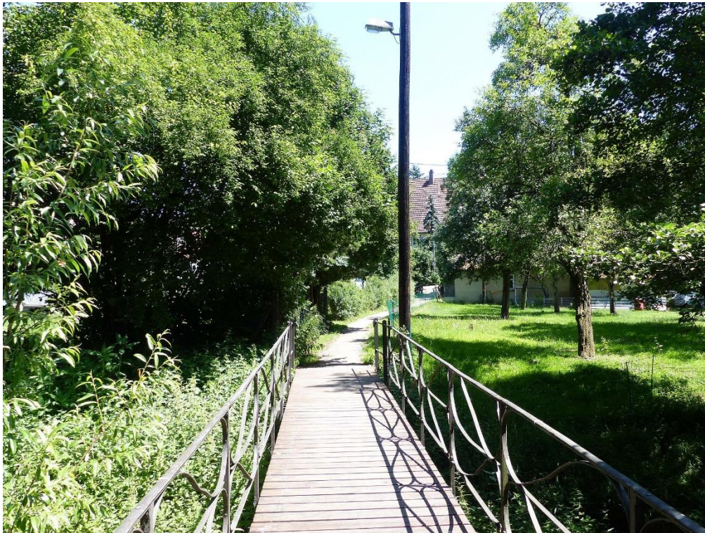
Abb. 4.40: Brücke über Wieslauf (Bestand)
