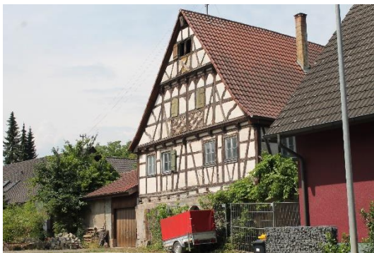
Abb. 4.6: Denkmalgeschütztes Gebäude mit umfassendem Modernisierungsbedarf Stuttgarter Straße, Haus Nr. 16 [WHS 2019]
